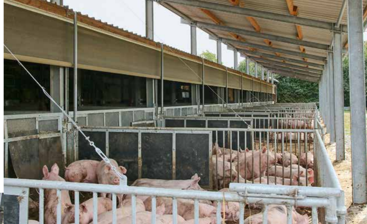
◁ Auch der 4 m breite Auslauf des Vormaststalls ist komplett überdacht. Die Buchtentrenngitter hängen an Stahlseilen, damit sie leichter zu schwenken sind.
