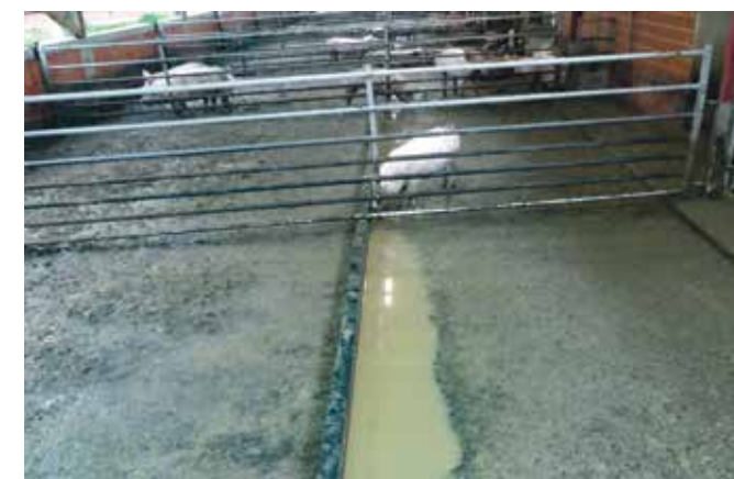
Stauschwellen sind außerhalb der Suhlzeit bei fehlender Einstreu nachteilig.
