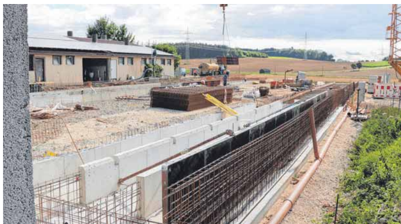
Ein innovativer Ferkelaufzuchtstall entsteht am Beurer Weg in Westerheim.
