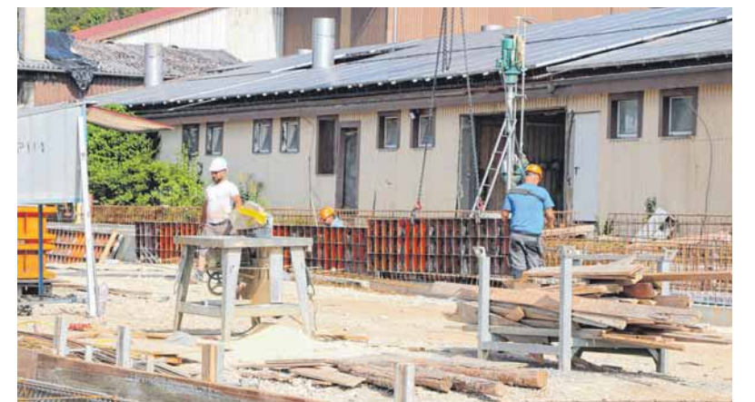
Ferkelaufzuchtstall und Sauenarena sollen bis Weihnachten stehen. FOTOS: STEIDLE
